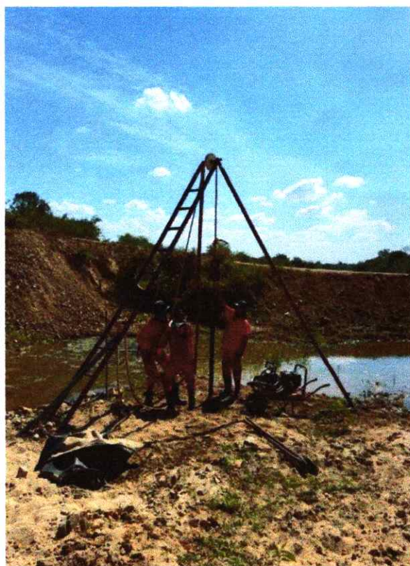
Figura 8. Execução de sondagem SP-04
