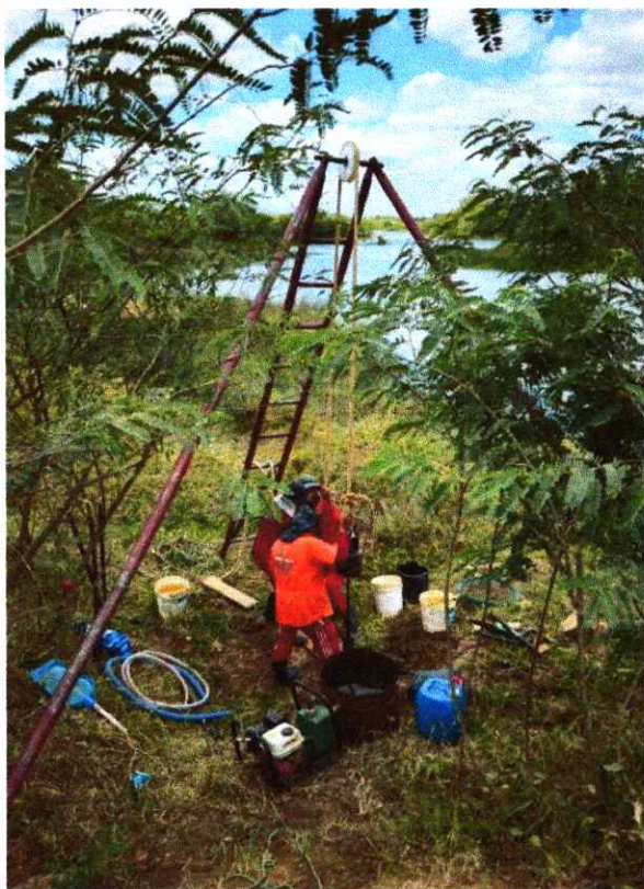
Figura 6. Execução de sondagem SP-03
