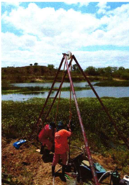
Figura 4. Execução de sondagem SP-02
