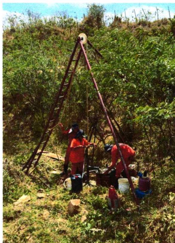
Figura 7. Execução de sondagem SP-03
